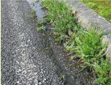
En effet, les dépôts cumulés durant l'hiver obstruent le bon écoulement des eaux pluviales dans le réseau d'assainissement en cas d'orage intense comme celui de fin juillet 2024 et favorisent la pousse d'herbes et adventices.
